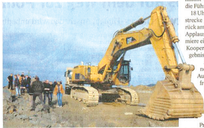
Hier in Berlar hat der Allrad-Bus seinen Meister gefunden: der größte Bagger des Steinbruchs, 85 Tonnen schwer, eine Schaufelladung fasst zehn Tonnen Gestein.
